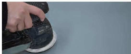
ユニプラルARTEは、特殊セメントモルタルを使用した、柔軟で弾性のある強固な塗膜が特徴。下地への高い追従性は、水平面、垂直面、屋内外、床面と、塗る場所を選びません。塗り厚は1mm程度で、什器やインテリアの仕上げ材としても最適です。
