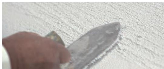
ユニプラル漆喰Tokyoは、特殊な配合によって、一度塗でテクスチャーが完成します。(ボードのつなぎ目とビス穴部分のみ下地処理) 施工の簡易化によりコストダウンを実現。高級仕上げ材の漆喰を、もっとたくさんの方々にご利用頂けるように、使いやすい価格でご提供致します。
