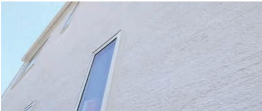
ユニプラルLimeは、奥多摩で採取された国産石灰と、強度を保つためのセメント、重厚な質感を出すための無機骨材で構成されています。消石灰は、漆喰の原料でもあり、空気中の二酸化炭素を吸収して長い月日をかけて硬化していく特長があります。ユニプラルLimeはこの仕組みを外壁に活用し、耐久性の高い壁を造りだします。
