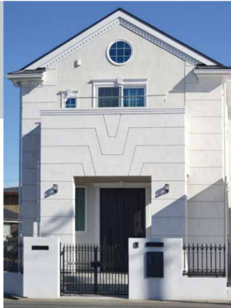
施工：ロビンスジャパン株式会社 外壁：ユニブラルHY+ #000 ノフ、ユニブラルSL #000 ライムストーン石積み
