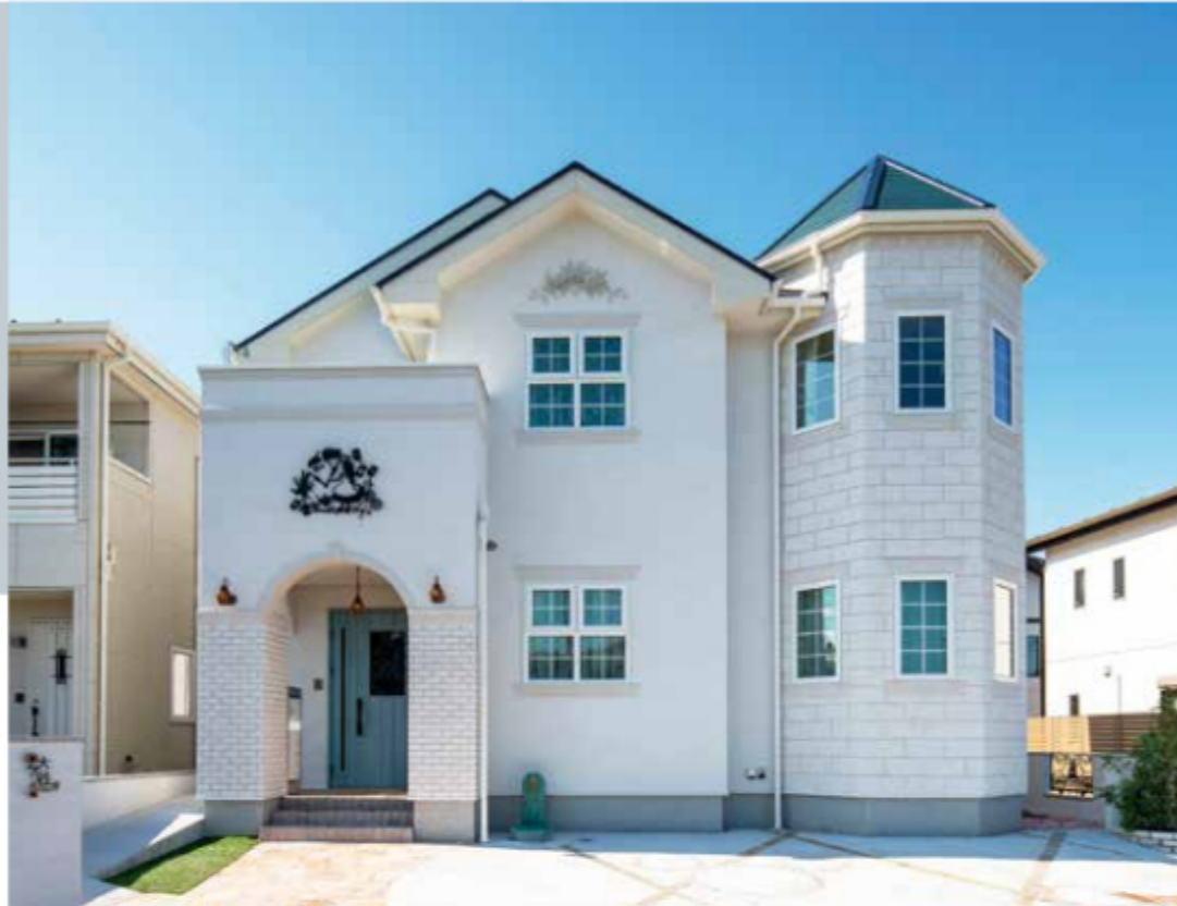
施工：株式会社土屋ホーム 外壁：ユニブラルHY+ #403 イビザ ユニブラルSL #403 ブリックレンガ調石積み、のこ肌石積み、モールディング装飾類、バラレリーフ
