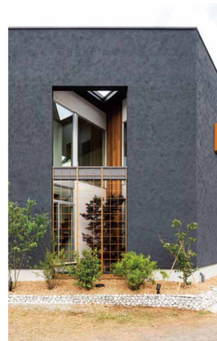
施工：共栄建築株式会社 外壁：ユニプラルHY+ #417 浮雲
