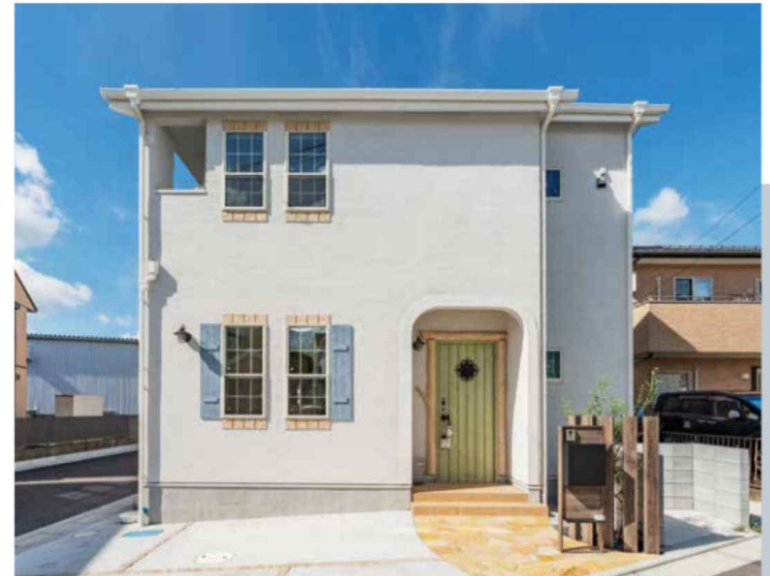
施工：株式会社Best Stage 外壁：ユニブラルSL #403 窓回り：ユニブラルSL #010 のこ肌石積み 鋸戸：ユニブラルSL 特注色 髪木
