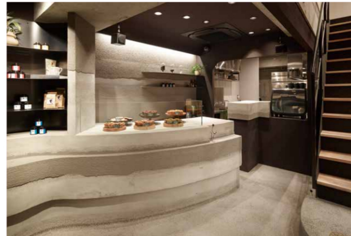
カフェタロー 設計：株式会社ルビオ岩崎デザイン事務所 壁・什器：ユニブラルSL #276 + #400他 ラ・テール 床：ユニブラルSL #276 + #400 洗い出し photo：©佐藤振一
