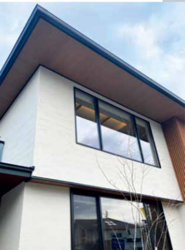
古河林業 古瀬展示場 施工：古河林業株式会社 外壁：ユニブラルHY+ #000 フレスコ
