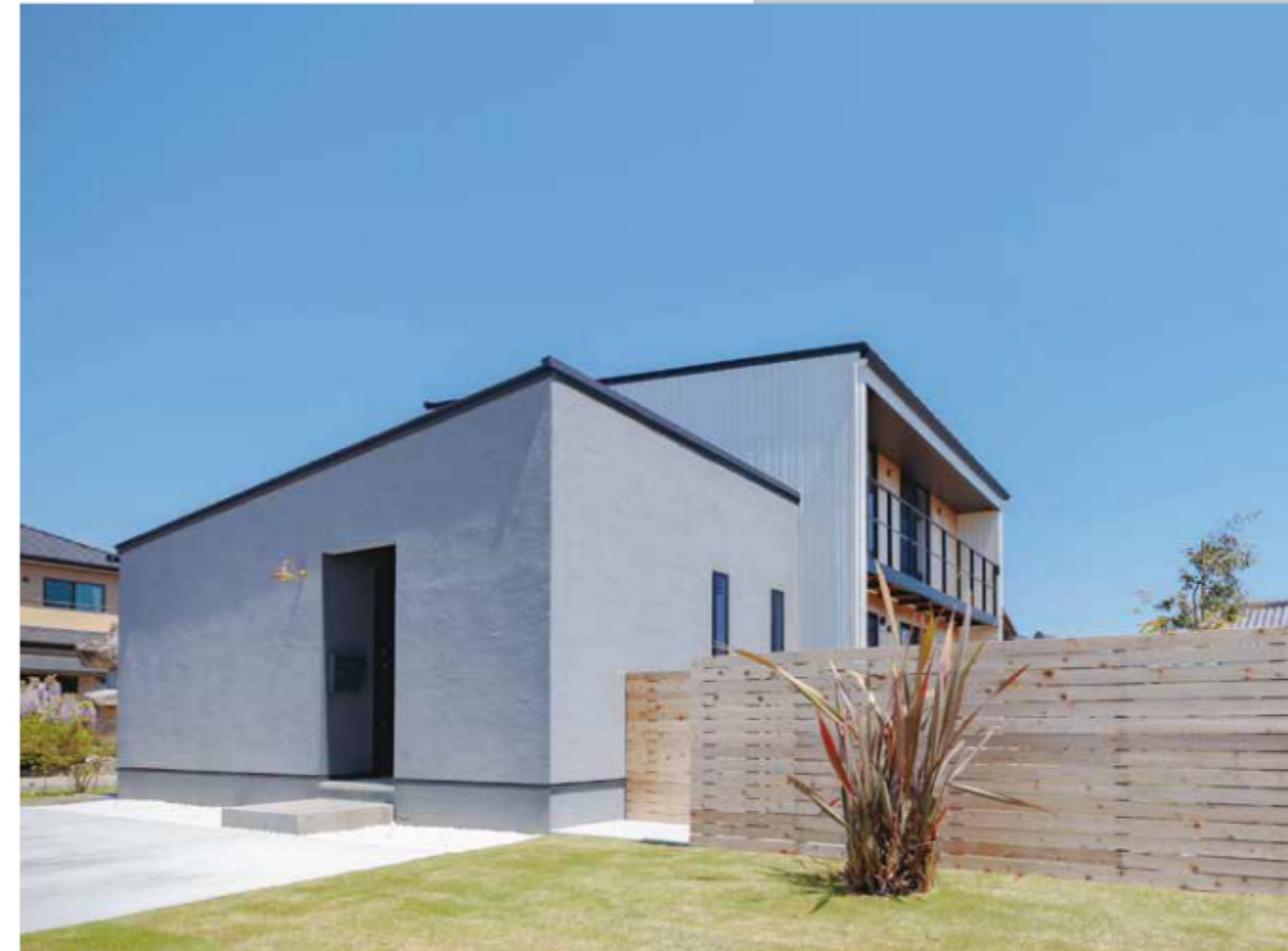
施工：株式会社Kibaco 外壁：ユニブラルHY+ #400 #417 イビザ
