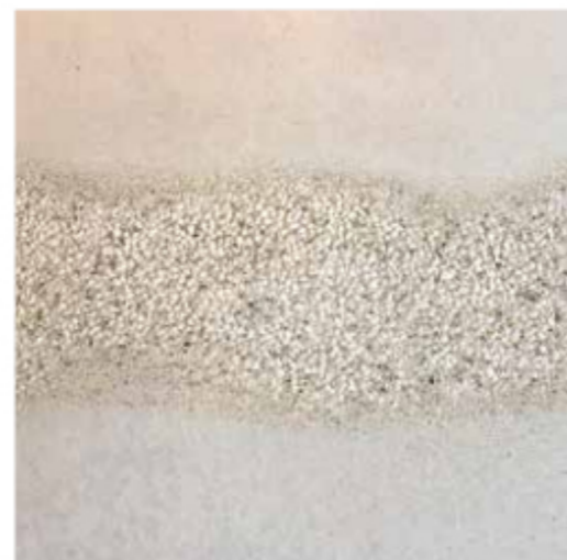
洗い出しライン 壁面をライン状に洗い出します。 ※全体に大きめの骨材を混ぜ合わせて作ります。 仕上厚：10~15mm
